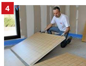
4 POSE DES PLAQUES ISOLANTES
