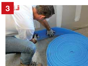
3 MISE EN PLACE DE L'ISOLATION PÉRIPHÉRIQUE
