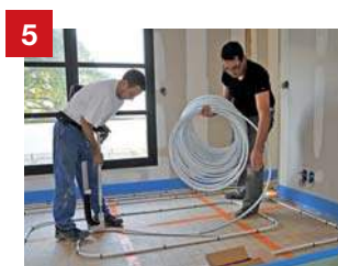
5 POSE ET FIXATION DES TUBES
