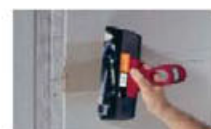
Technique de joint à bord aminci (technique traditionnelle avec bande).
